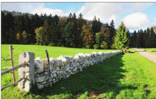
Cent cinquante mètres de murs en pierres sèches ont été restaurés aux Vieux-Prés. (SP)
